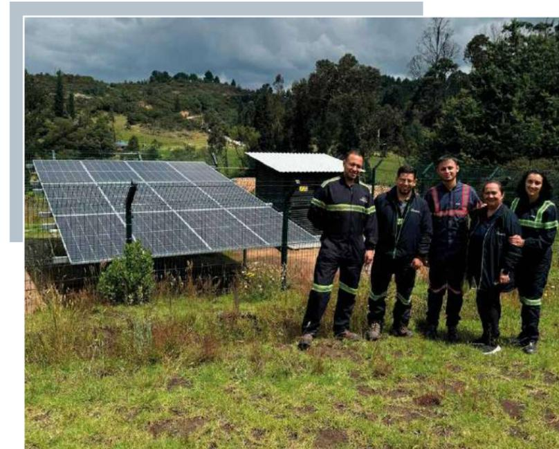
Se instaló un sistema solar fotovoltaico híbrido (SSF) en la sede de la Fundación Grupo Coquecol – Casa La Perla, ubicada en Cundinamarca. Este sistema cuenta con **12 paneles solares** y genera aproximadamente **637 kWh mensuales**. Además, dispone de una batería de respaldo que garantiza un suministro de energía constante.
